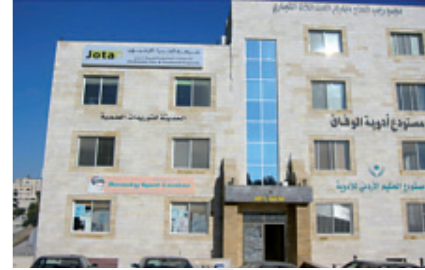
Façade extérieure du bâtiment MSS à Amman Fachada exterior de MSS en Ammán
