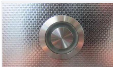
Ahora se puede abrir la puerta del lado de la sala blanca. Para volver a bloquear el lado de la sala blanca, pulse el botón de transferencia hasta que el perno de bloqueo se desplace hacia abajo. Esto bloquea la puerta en el lado de la sala blanca y desbloquea la puerta en el lado de la sala gris después de aproximadamente 4 segundos. Esto impide que las puertas se abran al mismo tiempo.
