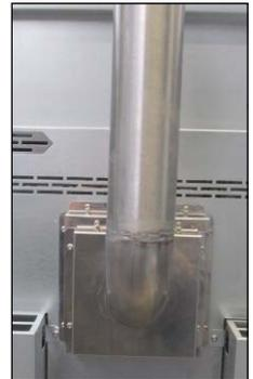
Abb. 6 Abluftrohr muss nach oben zeigen
