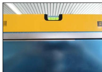
Abb. 12 Ausrichtung mit Wasserwaage
