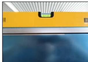
Abb. 12 Ausrichtung mit Wasserwaage
