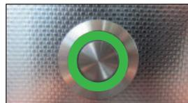
Vous pouvez maintenant ouvrir la porte du côté salle blanche. Pour verrouiller à nouveau le côté salle blanche, appuyer sur la touche de transfert jusqu'à ce que le boulon de verrouillage se déplace vers le bas. Cela verrouille la porte du côté salle blanche et déverrouille après env. 4 secondes celle du côté salle grise. L'ouverture simultanée des portes est ainsi exclue.
