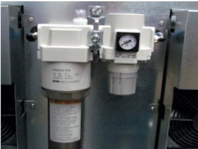
С помощью программного обеспечения устройства осуществляется управление магнитным клапаном, который регулирует поток воздуха для обеспечения требуемого снижения влажности. Ручное регулирование модуля осушения сжатым воздухом требуется только в экстремальных условиях.
